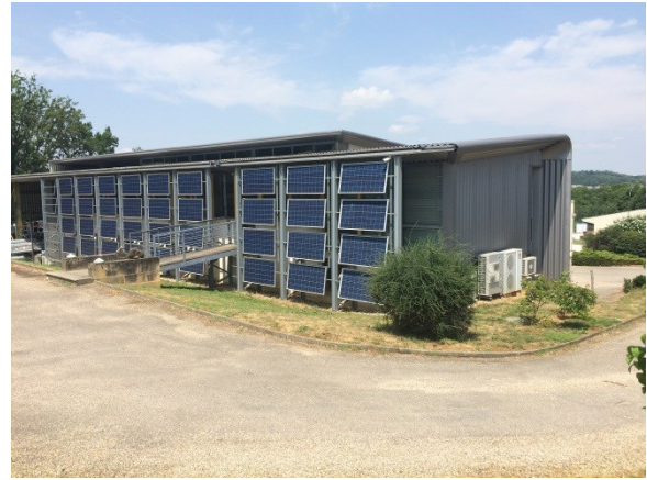
250 m 2 de capteurs photovoltaïques pour une production annuelle estimée de 30 000 kWh
